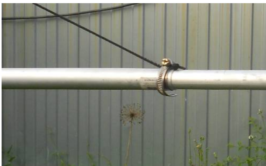
Рис. 4. Соединение двух трубок.
