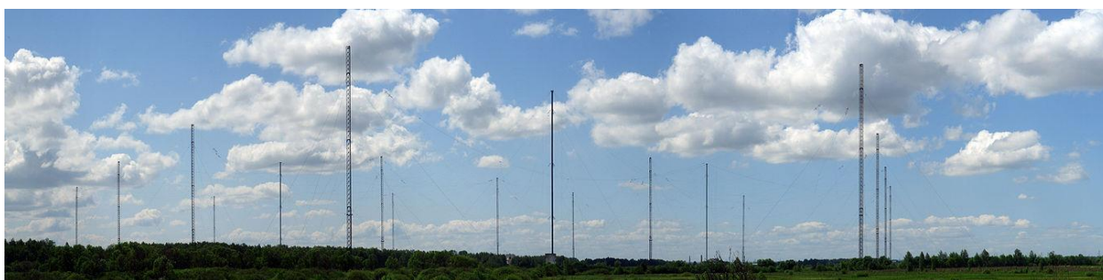
Рис. 5. Мачты «Голиафа» (из [5]). Тросы, образующие «зонтики», в таком масштабе почти не видны, они натянуты между центральными и периферийными мачтами.
